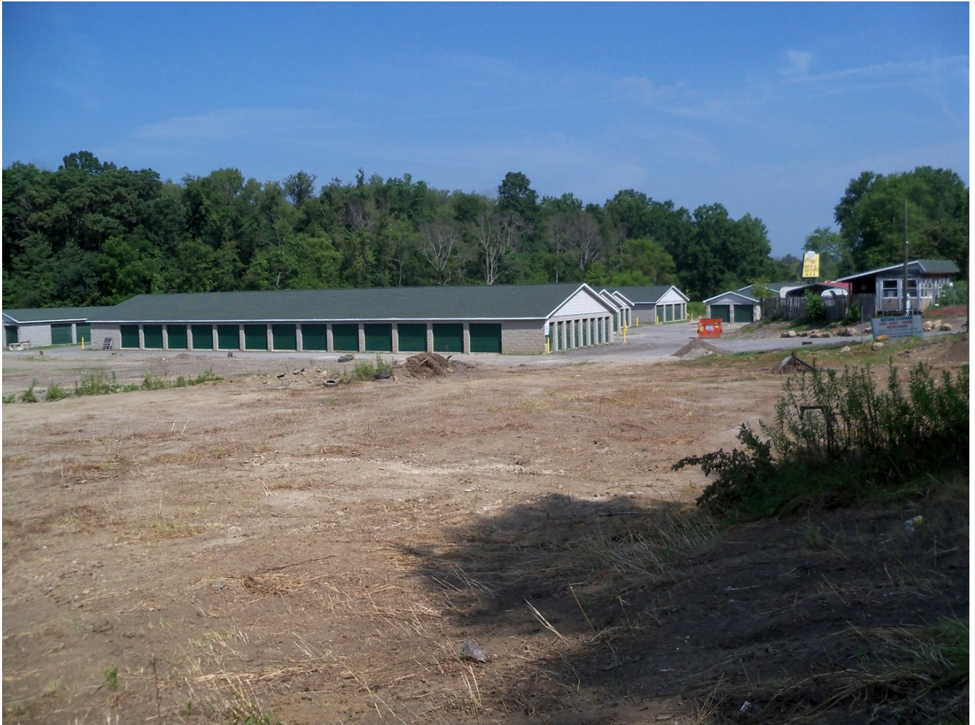
Hoffmeier Mini Storage North Sewickley Township
